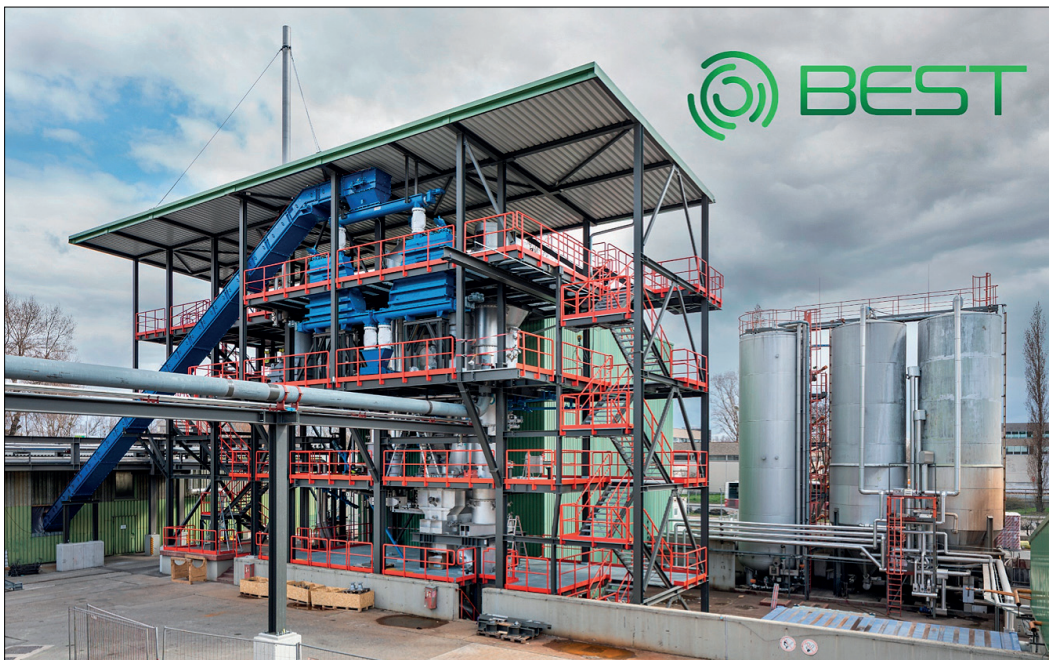
Oben: Ergebnisse der Biomasse-Potenzialanalyse (links), erreichbare Produktgaszusammensetzung (rechts) Unten: 1 MW aDFB Gaserzeuger der Syngas Plattform Vienna
